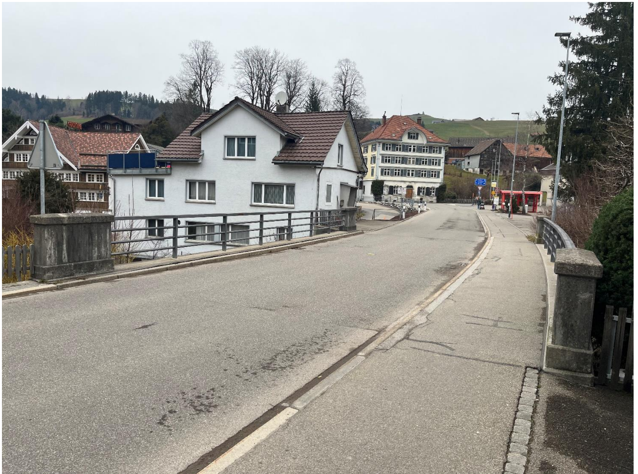
Bildlegende: Tüfenbachbrücke, Schönengrund
